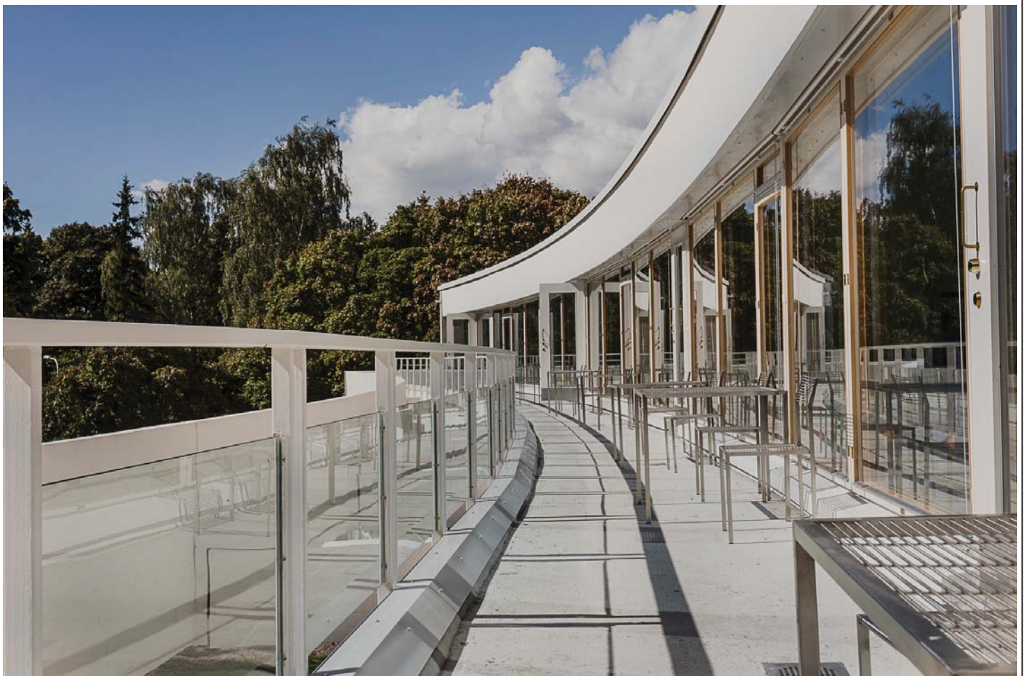
Yksi Töölön kirjaston peruskorjauksen pää tavoitteista oli avata uudelleen sisätiloja puistoon. Parvekkeet ja terassit olivat vuosien saatossa päässeet erittäin huonoon kuntoon ja pääsy niille oli turvallisuussyistä kielletty. Yllä 4. kerroksen parveke uusine kalusteineen peruskorjauksen jälkeen.
