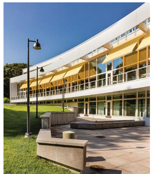
Kirjaston julkisivu topeliuksen puiston suuntaan peruskorjauksen jälkeen kesällä 2016. Eteläjulkisivun suuret ikkunat kunnostettiin, lasitukset vaihdettiin ja markiisit palautettiin, toimenpiteillä pienennettiin suurten salien lämpökuormaa. Etualalla ensimmäisen kerroksen terassi.
