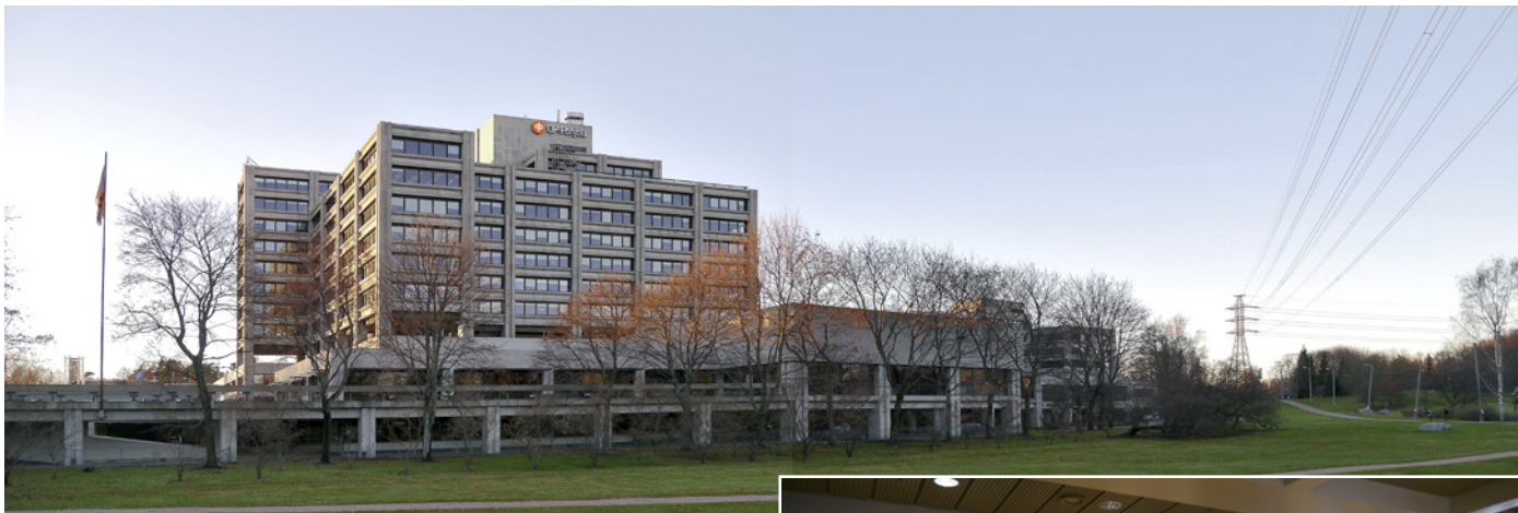
POHJOLAN TOIMITALO KANGASPELLONPUISTON PUOLELTA VUONNA 2013.
