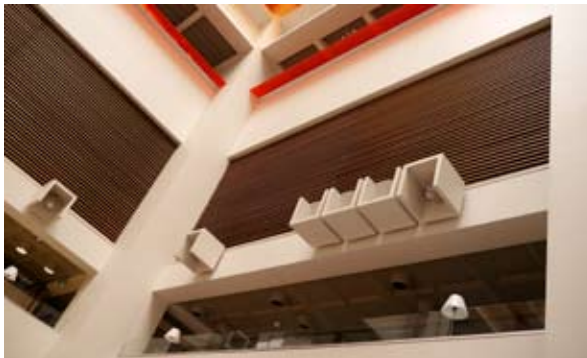
↓ Aulatilalle antavat lisäilmeitä betonista valetut alkuperäisvalaisimet. Tekniikkakerros aukeaa sisäaulaan ilastointisäleikköinä. amoy 2013
