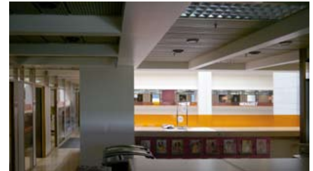
↓↑ Palkiston suunnanmuutos sisäaulan ja ulkoseinän kulmassa. amoy 2013
