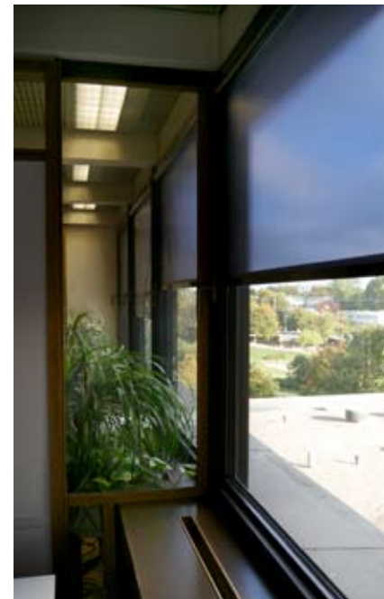
↑ Ikkunapenkkeihin liittyy ilmanvaihdon sekoitusyksikkö ja sekoitetun ilman jakokanavat. Kuva rakennusvaiheesta. LVI-Pohjolassa s. 37 → Jakokanavan alapuolinen osa on käytetty kaappitilana siellä, missä ei ole sekoitusyksikköä. 10. krs:ssa kaapin ovet on vaihdettu lasisiksi. amoy 2013
