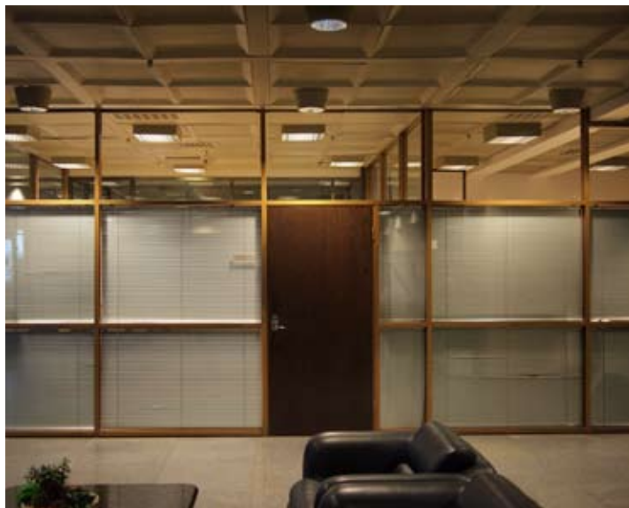
↑ 1. kerroksen alkuperäisissä vahtimestarin tiloissa on vanhoja alumiinilasiseinärakenteita eloksoidulla listoilla. amoy 2013 ➤ 1. kerroksen kirjastossa ja musiikkihuoneessa on jäljellä vanhoja teräslasiseinärakenteita. amoy 2013
