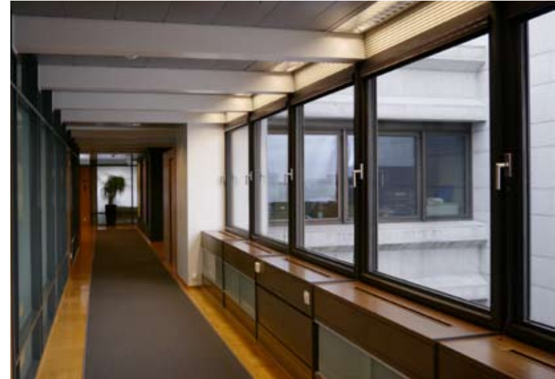
↑ Ikkunapenkkeihin liittyy ilmanvaihdon sekoitusyksikkö ja sekoitetun ilman jakokanavat. Kuva rakennusvaiheesta. LVI-Pohjolassa s. 37 → Jakokanavan alapuolinen osa on käytetty kaappitilana siellä, missä ei ole sekoitusyksikköä. 10. krs:ssa kaapin ovet on vaihdettu lasisiksi. amoy 2013
