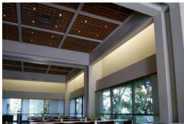
↑ Reunapalkin taakse piilotetuista loisteputkivalaisimista tulee seinäpinnoille epäsuoraa valoa. amoy 2013
