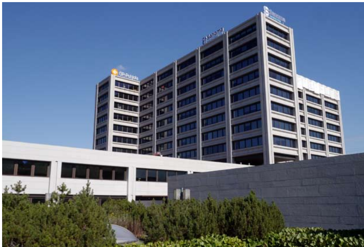
↑ Erilaiset graniittijulkisivutyypit: torniosan ikkunaseinä, jalustaosan ikkunaseinä ja tasainen umpiseinäpinta. Näkymä lounaasta. amoy 2013
