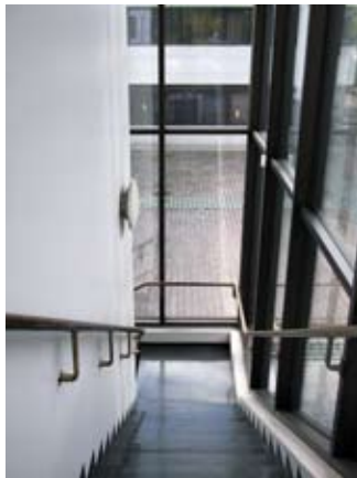
↓ Kuvat alla: Laajennusvaiheen jalustaosan poistumistieportaavat sijaitsevat sakaroiden tai poikkisiipien umpipäädyissä. amoy 2013.
