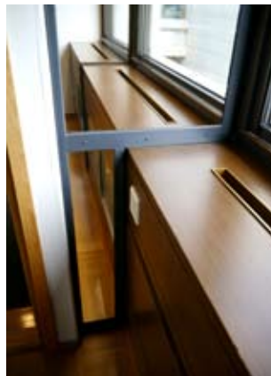
↑ Ikkunapenkkeihin liittyy ilmanvaihdon sekoitusyksikkö ja sekoitetun ilman jakokanavat. Kuva rakennusvaiheesta. LVI-Pohjolassa s. 37 → Jakokanavan alapuolinen osa on käytetty kaappitilana siellä, missä ei ole sekoitusyksikköä. 10. krs:ssa kaapin ovet on vaihdettu lasisiksi. amoy 2013
