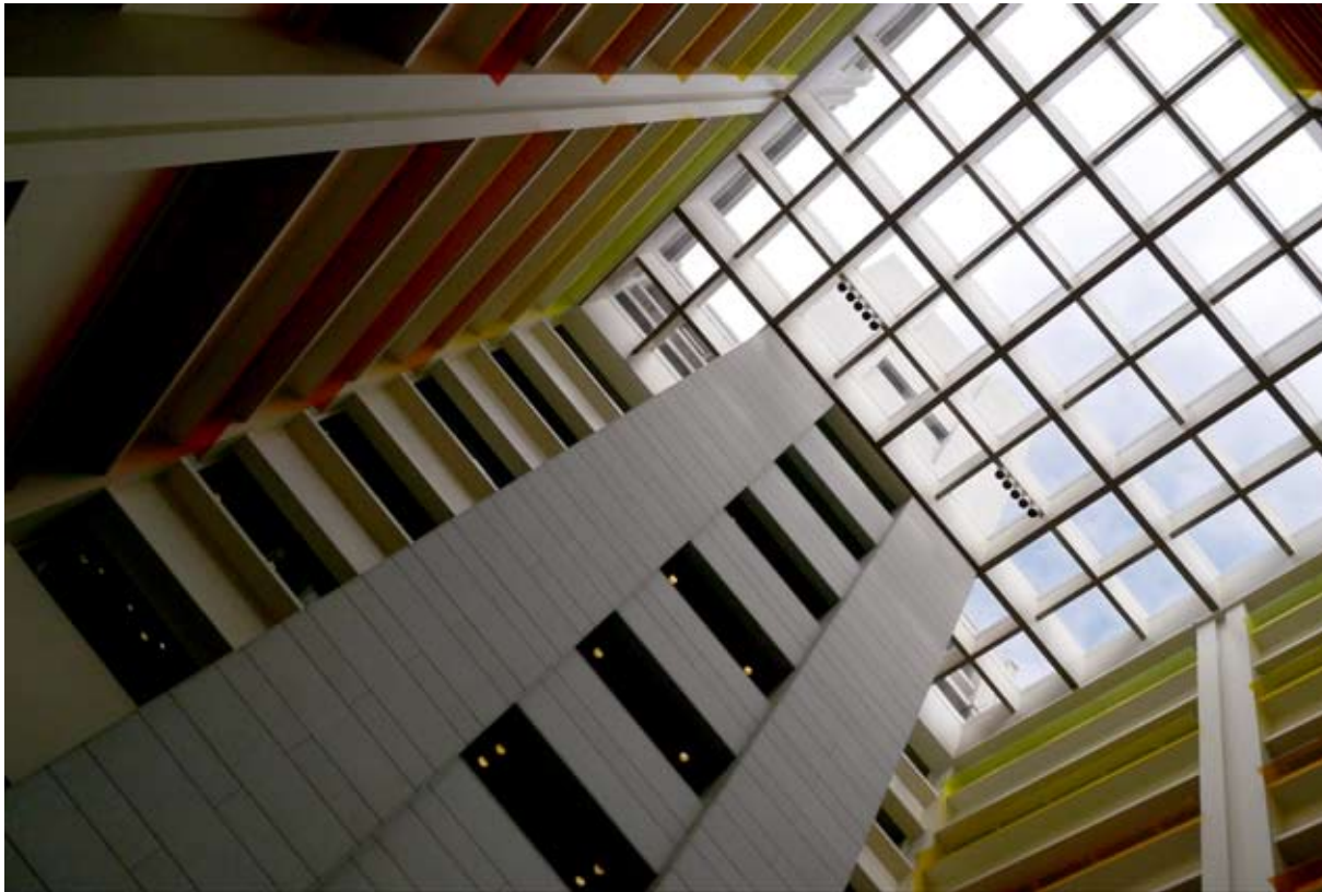
↓ Aulatilalle antavat lisäilmeitä betonista valetut alkuperäisvalaisimet. Tekniikkakerros aukeaa sisäaulaan ilastointisäleikköinä. amoy 2013
