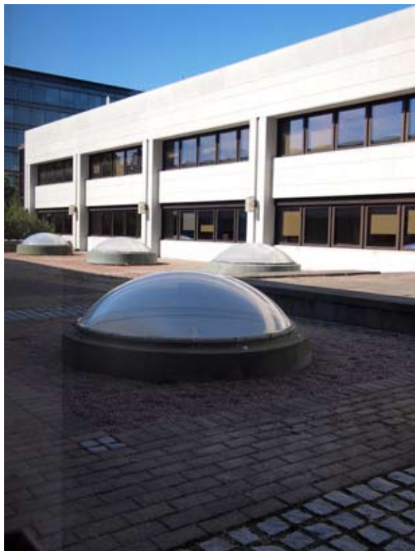
↑ Rakennuksen länsipuolen siipien välisillä sisäpihoilla on vielä jäljellä joi- tain alkuperäisvaiheen suuria kattokupuja. Etualalla alkuperäinen, taa- empana laajennusvaiheen kattoikkunoita. amoy 2013
