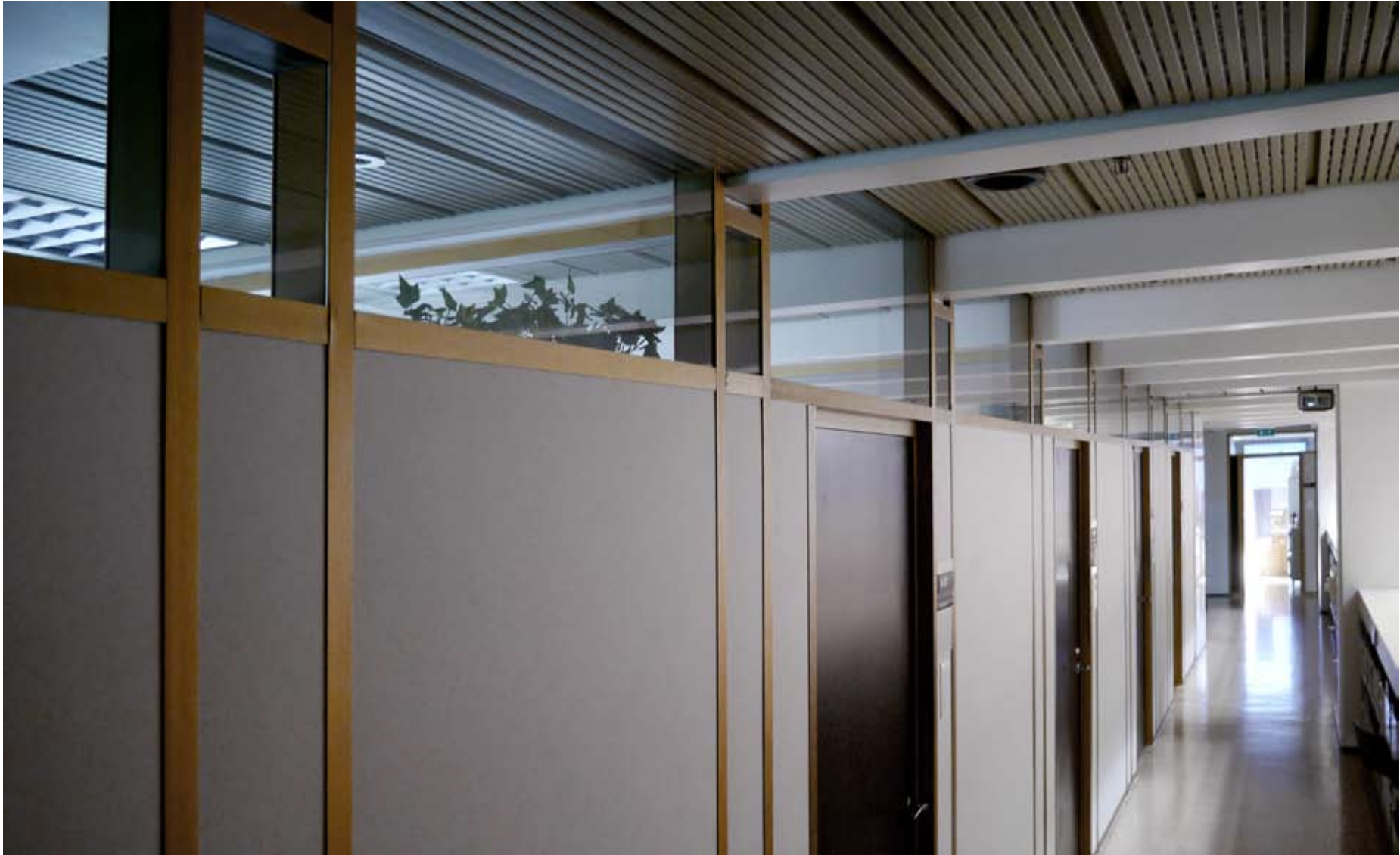
↑ Näkymä A-tornin 5. kerroksesta. Toimistotilat on toteutettu alkuperäisellä väliseinäjärjestelmällä. Alakatot jatkuvat yhtenäisinä käytäviltä toimistotiloihin. amoy 2013
