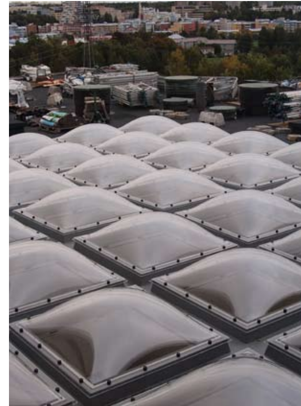
↑ Alkuperäisvaiheen kattoikkunoita päältä päin kuvattuna. Vasemmalla kolmikuinen soikea kattoikkuna, keskellä kirjapainosalin suuret pyöreät kattokuvut ja oikealla pääaulan valokatto. Viimeksimainitut on hiljattain uusittu entisen kaltaisina. amoy 2013
