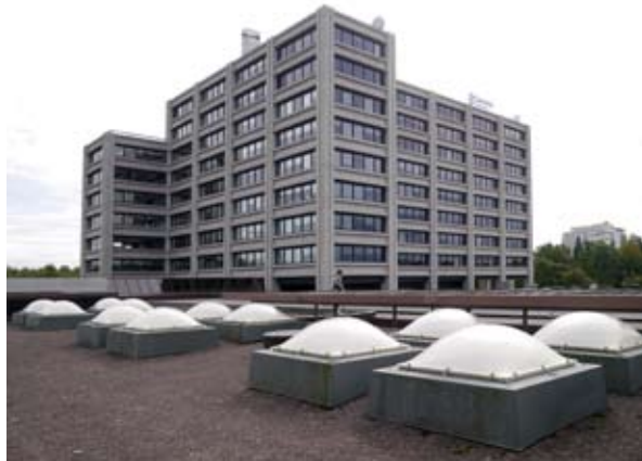
↑ Pilariruusukkeisiin liittyviä neljän kupuikkunan sarjoja toisen kerroksen katolla. amoy 2013
