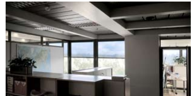
↓↑ Palkiston suunnanmuutos sisäaulan ja ulkoseinän kulmassa. amoy 2013
